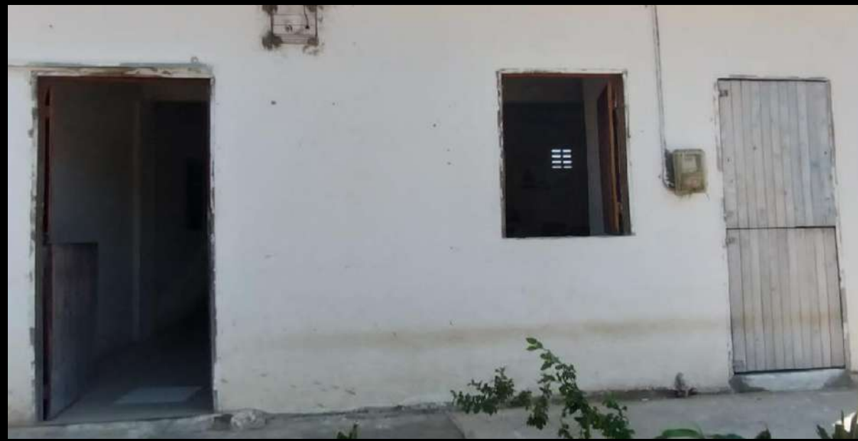
Frente do Terreiro, 2023 - com reboco e pintado
